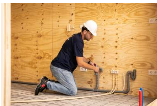
Leidingwerk en riolering
