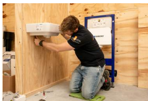
Toilet, wastafel, mengkraan en ventilatie boxen
